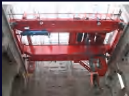
发电-汽轮机组安装吊运
