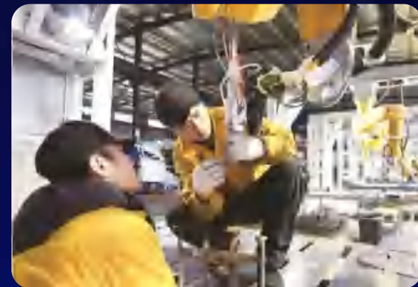
检修维修 (多人)
